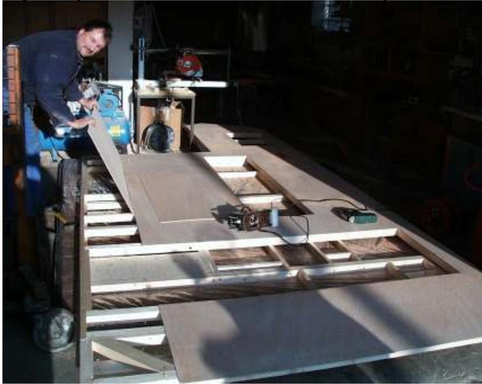
Dachelement bogenförmige Rippenhölzer außen 45mm Dachmitte 90mm
